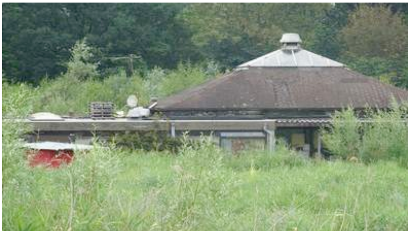
hoofdgebouw op het terrein van de Rakkers in het Riet
