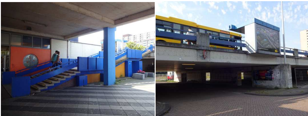
Helder en strak geometrisch vormgegeven trappartij die het plein verbindt met de verhoogde de Th. Weeversweg, met de mee ontworpen bushokjes (vermoedelijke architect D. Sterenberg van de Dienst Publieke Werken)
