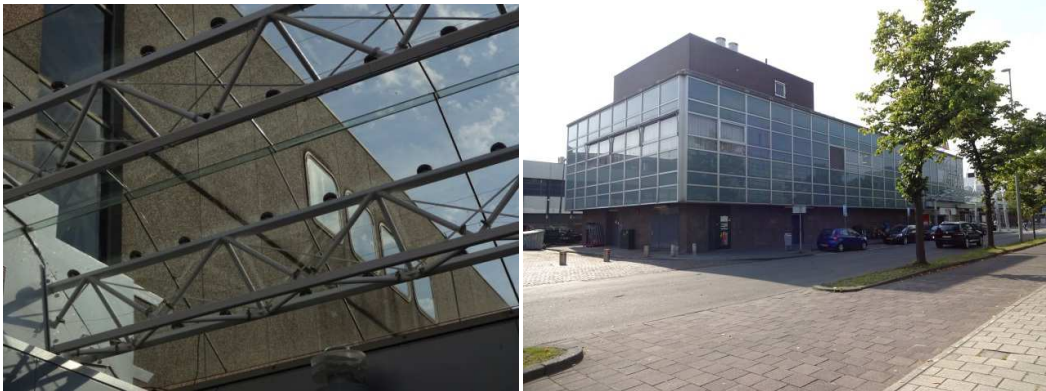
Gebruikte materialen zijn o.a. grindbeton en glas (het glas op de linkerfoto is de glasoverkapping uit de jaren 90)
