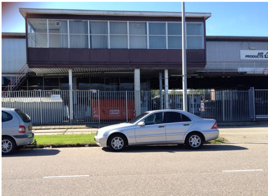
Fig.2 Hoofdgebouw Air products aan de Distelweg
