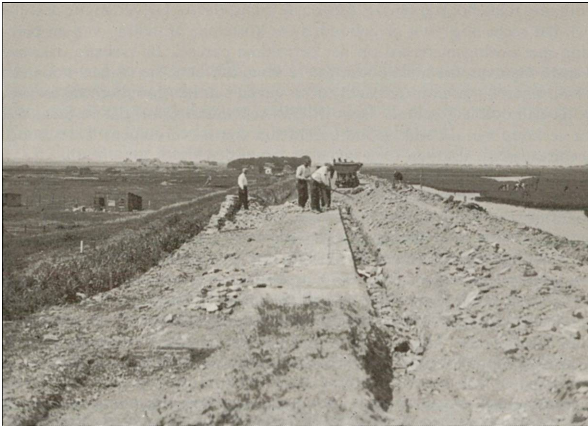
7 Sloop van de bovenbouw van de stenen beer van Post Kouhorn in 1929 (foto Belogne 1973)
