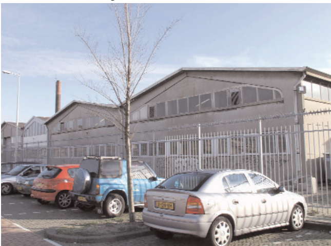
Onder: de vier voormalige DRAKA-hallen, alleen de eerste twee en de laatste hebben betonnen kniespantconstructies en T-daken (rechterfoto)
