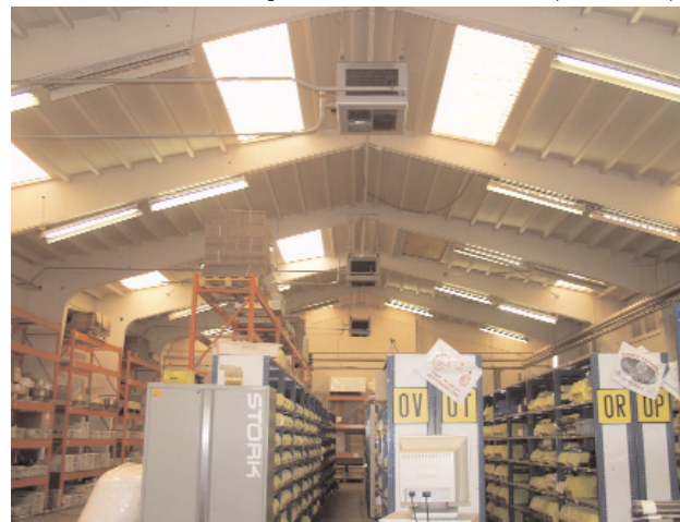
Onder: de vier voormalige DRAKA-hallen, alleen de eerste twee en de laatste hebben betonnen kniespantconstructies en T-daken (rechterfoto)
