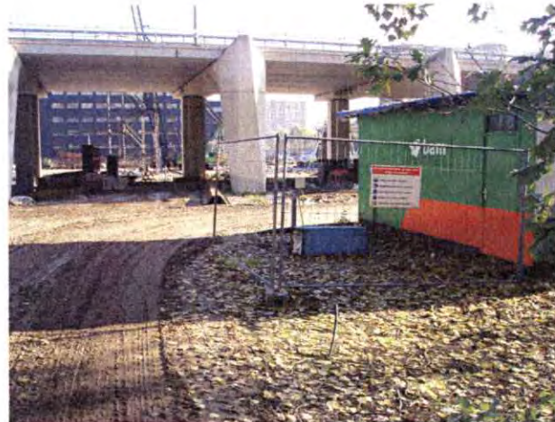
Foto 4: Bouwterrein, in oostelijke richting gezien
