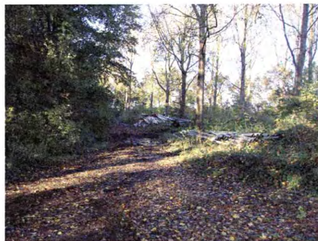
Foto 12: Bouwweg met opslag materialen
