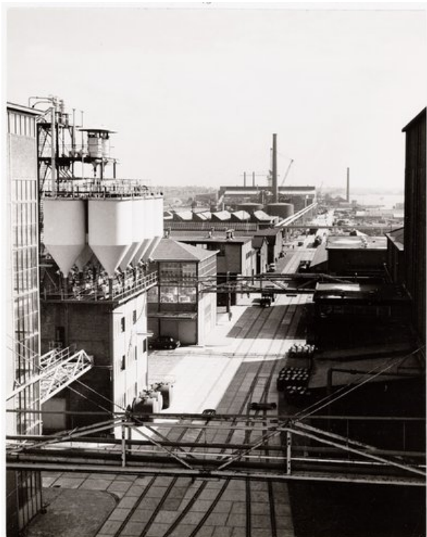
De oost-west georiënteerde industriestraat met links op de foto enkele gebouwen van Merkelbach. De katalysatorfabriek springt het meest in het oog. (Bron: Stadsarchief Amsterdam).
