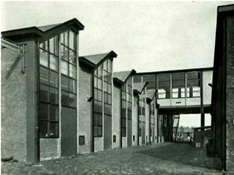
Magazijn met bedrijfsrestaurant gezien in noordelijke richting. (Bron: Bouwkundig Weekblad 1956, p. 244).
