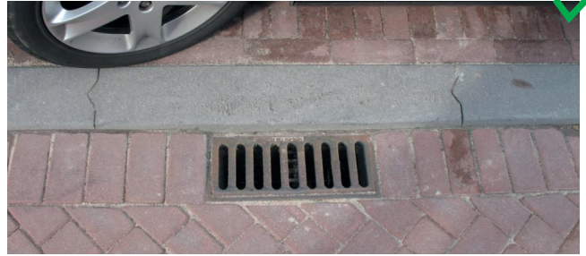
Detail van goede toepassing van een 45x20 valkolk met rollaag
