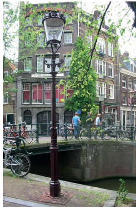
Klassieke mast (1867, slanke uitvoering) met Ritterarmatuur
