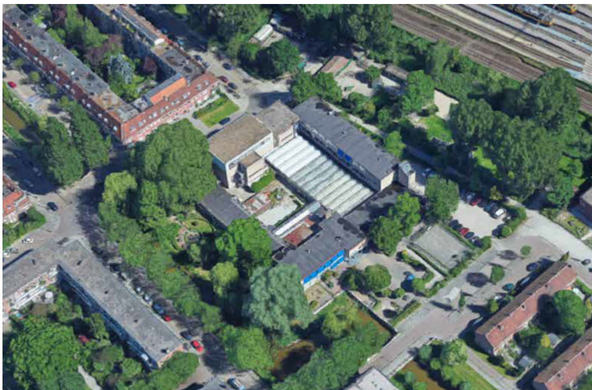
Foto bestaande situatie
