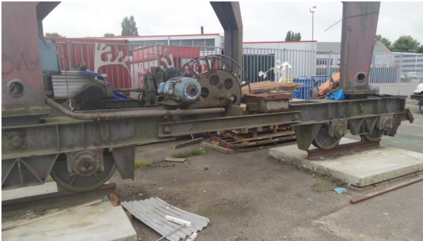
Foto 5.1: Oude kraanspoor (zuidoostzijde buitenterrein) (25 juli 2016)
