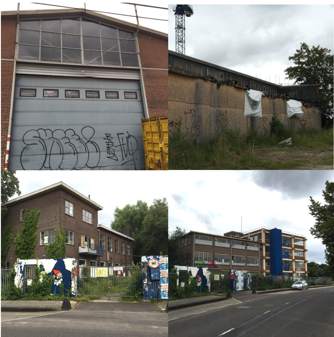
Figuur 4 Boven: de Remepa-loods, voorgevel blijft behouden, zijgevel met bouwvallig dak maakt deel uit van de reconstructie. Onder: bebouwing Sigma terrein.
