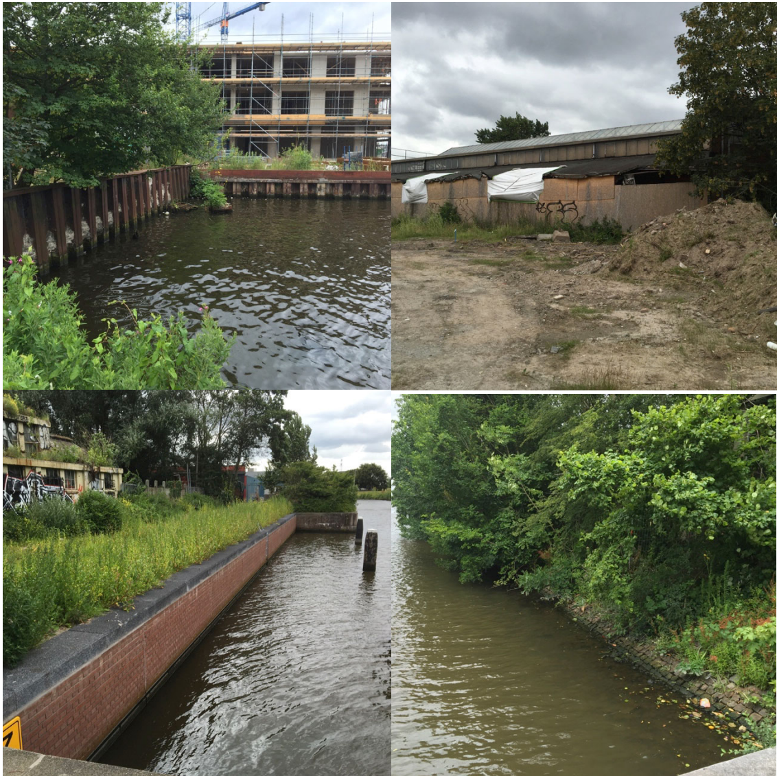
Figuur 3 De oevers achter de Remepa-loods met stalen damwanden (boven links), het braakliggend terrein ernaast (boven rechts) heeft een stortstenen oever. Onder: kade en stortstenen oever langs Sigma te Amsterdam.
