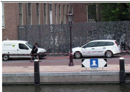
Figuur 4.2.1 Aanmeerpalen hangend/ geschroefd aan kademuur
