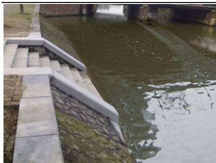
Figuur 4.2.2 Watertrappen verwerkt in kademuur
