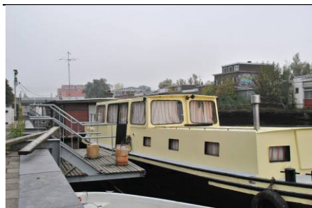
Figuur 4.2.2 Zwevende steiger, hangend aan kademuur
