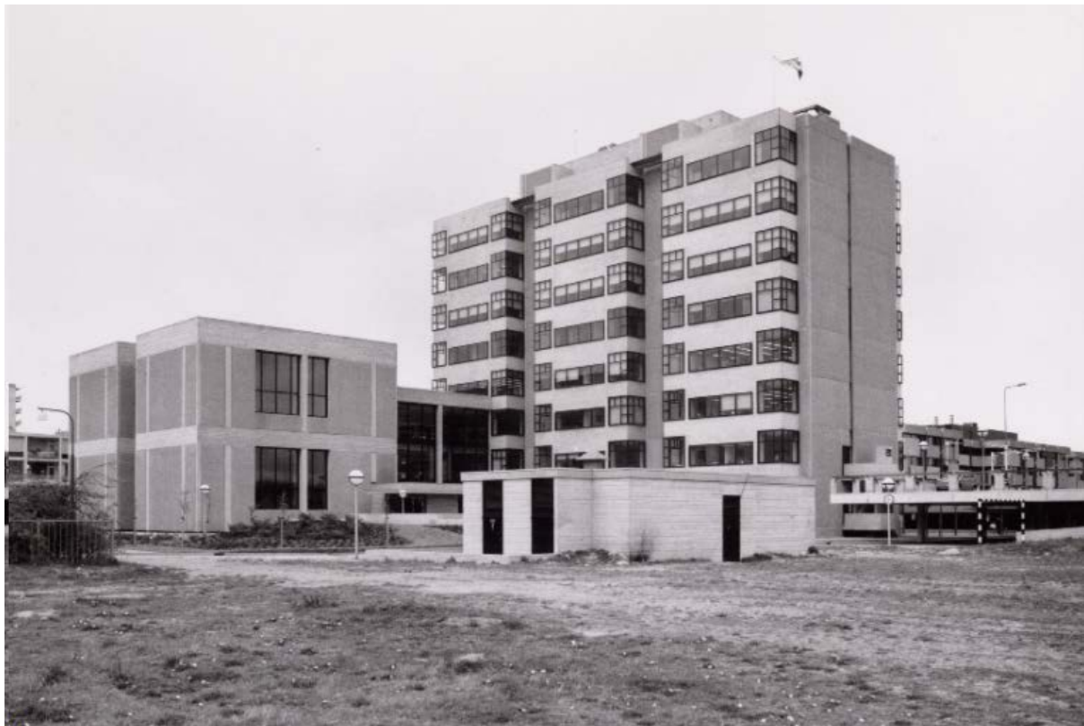
Afbeelding: rechtbankgebouw na oplevering
