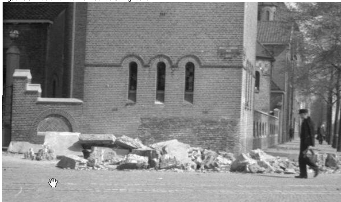
Figuur 3.5: Restanten bunker voor de St. Agneskerk.
