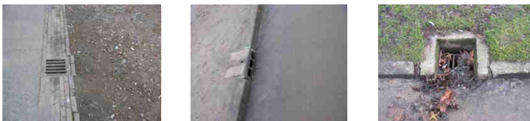
Figuur 9. Foto's van diverse straatkolken langs asfaltpaden in het Vondelpark.
