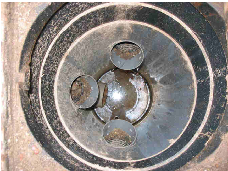
Figuur 7d. foto van een gerealiseerde af/aanvoerput
