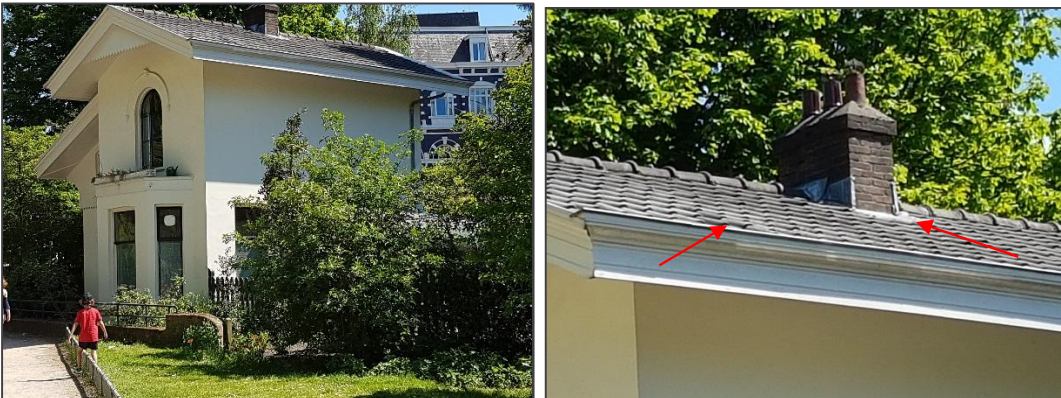
Figuur 18 en 19. Potentiele verblijfplaatsen vleermuizen.
