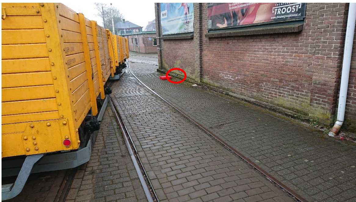
Figuur 1.7 Meetpunt 3 op fundatie loods
