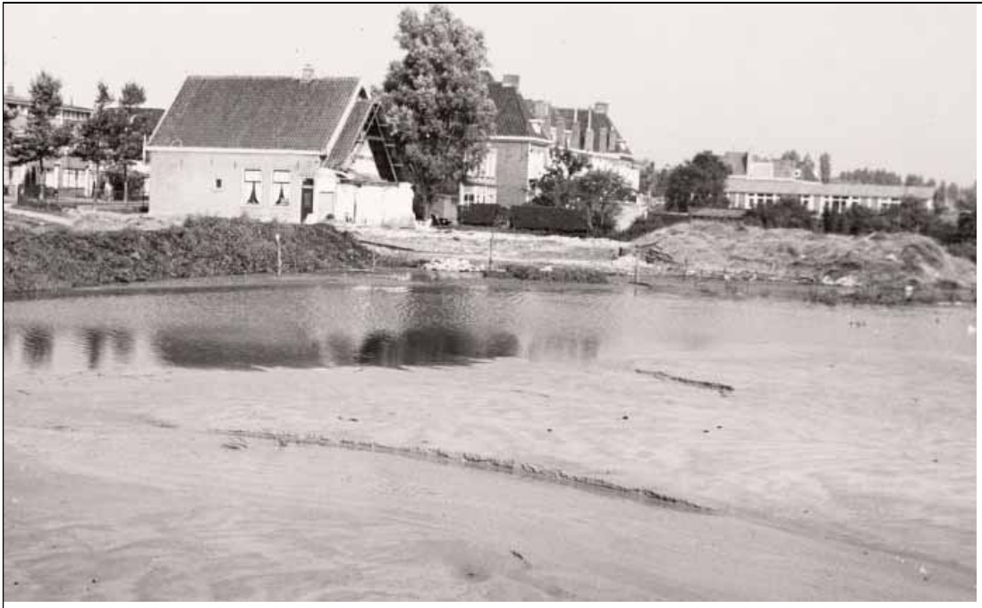
14 Boerderij Bouwlust/Buitenveldert tijdens de afbraak en het opspuiten van de polder in september 1955 (SAA)
