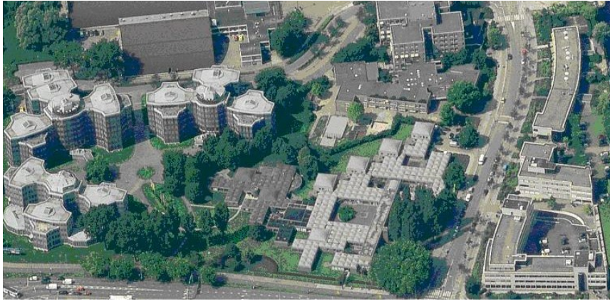
10. Bovenaanzicht bebouwing kantorenlocatie IJsbaanpad e.o.. Kenmerkend voor dit gebied zijn het Burgerweeshuiscomplex (midden onder op de foto) en Tripolis (links).
