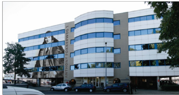
20 - Kantoorpand Anthony Fokkerweg 1
