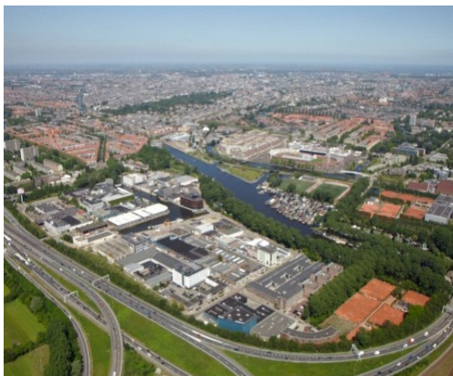
8 - Luchtfoto bedrijventerrein Schinkel
