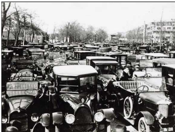
10 Het Stadionplein voor het Oude stadion naar het noorden met rechts woningblok hoek Stadionweg Amstelveenseweg in aanbouw en links boerderij Amstelveenseweg 344, ca. 1922 (SAA)
