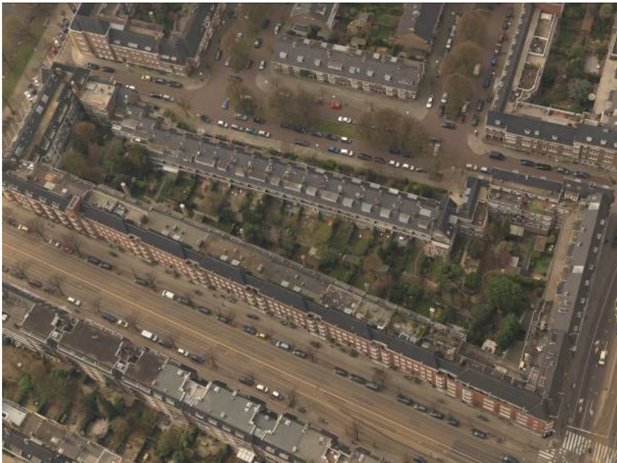
Woningbouwblok tussen Beethovenstraat en Holbeinstraat waarvan de zijden verschillende hoogtes hebben
