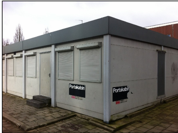
De porto cabines
