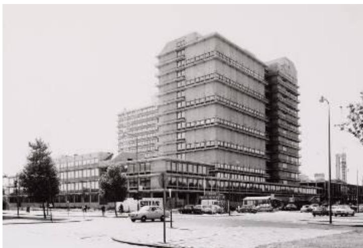
J.M. Arsath Ro'is, 1971 – Het hoofdgebouw van de Vrije Universiteit Amsterdam, gezien in zuidwestelijke richting.
