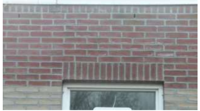
Detail muur openluchtschool met aan de bovenzijde van de foto twee openingen, waardoor vleermuizen spouwmuren kunnen bereiken
