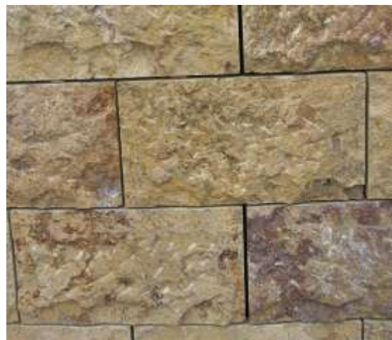
Detail van de siergevel van het Forum
