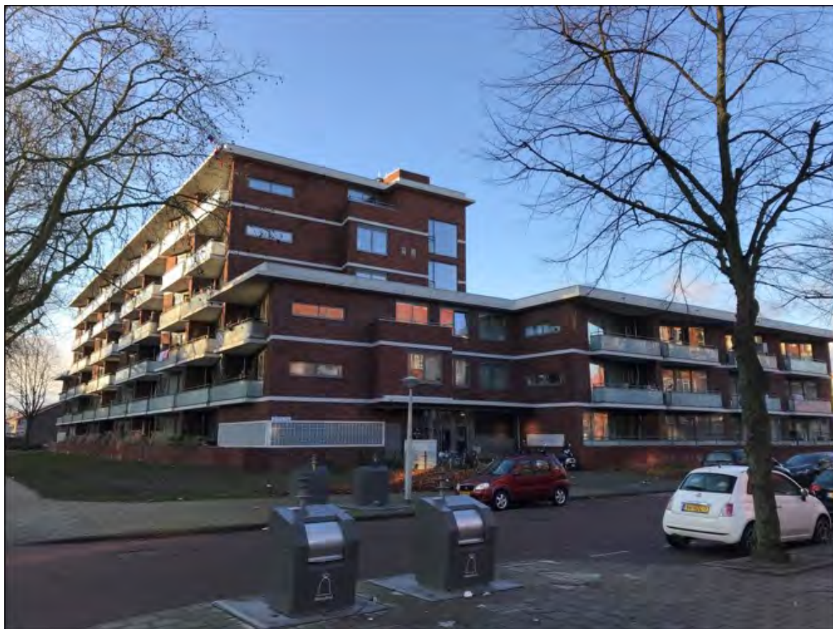
Afbeelding: het appartementencomplex ten westen van het plangebied, gezien vanaf de Comenuisstraat (bron: https://www.google.nl/maps/ )
