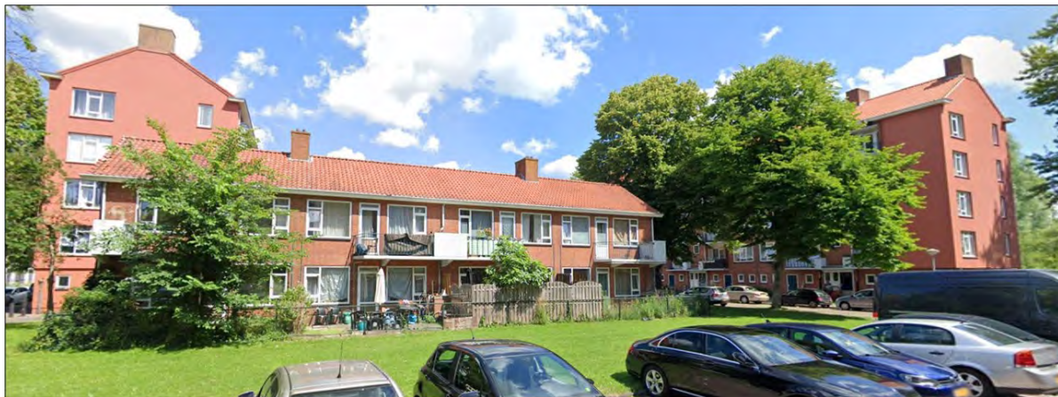
Afbeelding: middelhoogbouw en laagbouw, gezien vanaf het Hermanus van der Tuukhof (bron: https://www.google.nl/maps/ )
