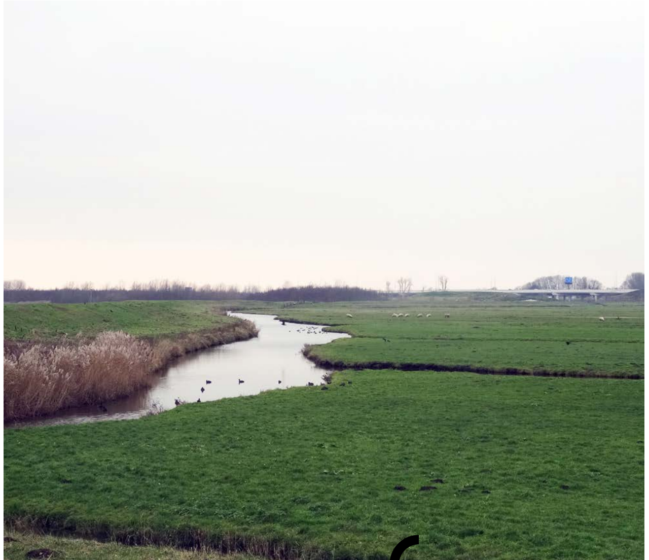
Zicht op de Osdorper Bovenpolder met rechts de Wijsentkade. Achter deze dijk ligt de Lutkemeerpolder.
