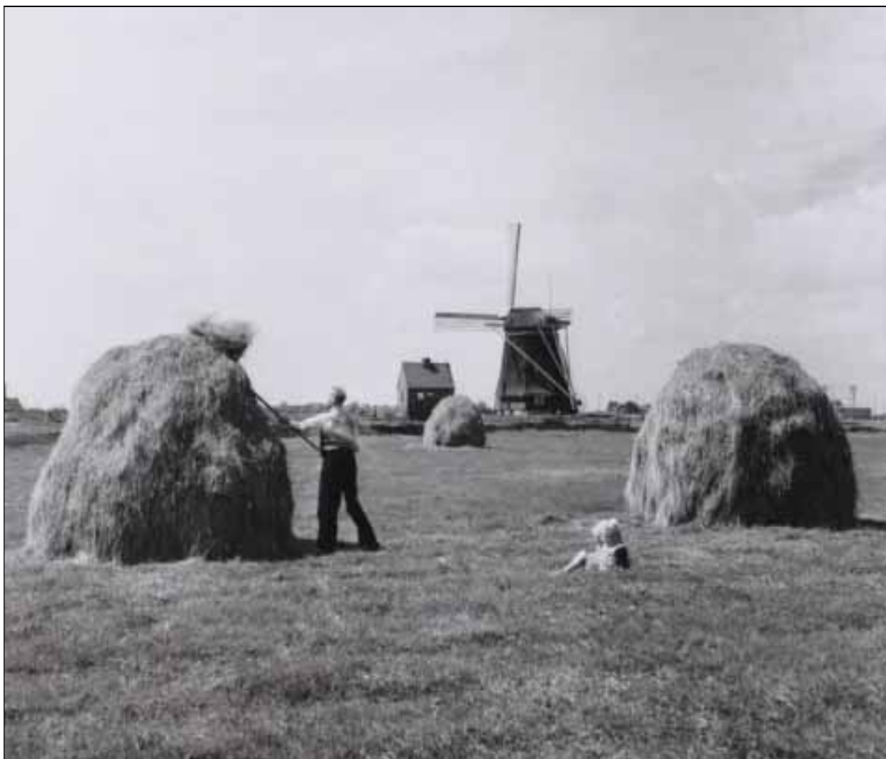
10 De Bovenwags- of Riekmolen op zijn oorspronkelijke plaats met het motorgemaal uit 1932 (foto 1954 coll. Ben Merk, SAA)
