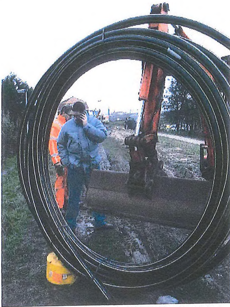
De gasleiding naar de molen wordt in de dijk gelegd
