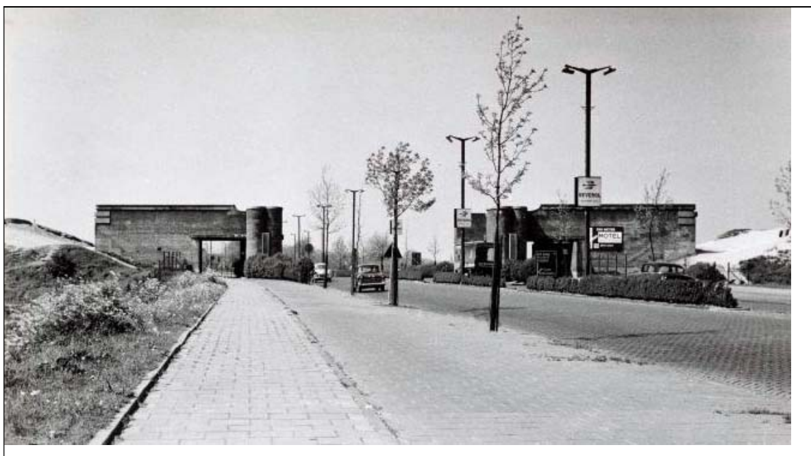
14 De Haagseweg bij het nooit voltooide viaduct in de onvoltooide ringspoorbaan (foto R. Knopper 1959, SAA)
