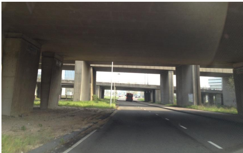
Afbeelding: viaduct Johan Huizingalaan
