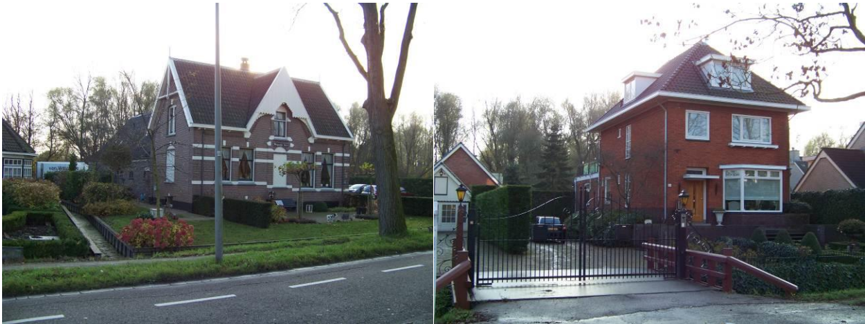
Afbeeldingen: Woonbebouwing langs de Sloterweg.
