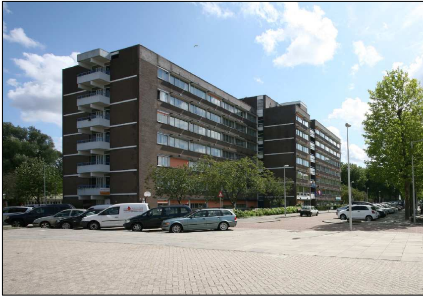
Afbeelding: het bestaande hotel, gezien vanaf de Reimerswaalstraat
