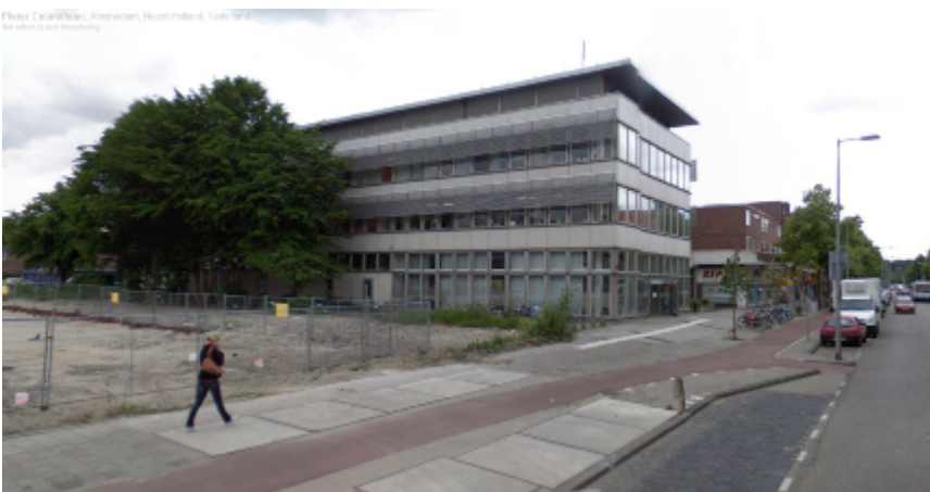
Bedrijfsgebouw (voormalige Naaimachinehandel) , C. de Geus, J.B. Ingwersen, 1964, Ariana Nozemanstraat Rechthoekig sober opgezet bedrijfsgebouw die architectonische waarde ontleent aan evenwichtige afwisseling open en gesloten geveldelen en een duidelijke bekroning met een plat dak met overstek.
