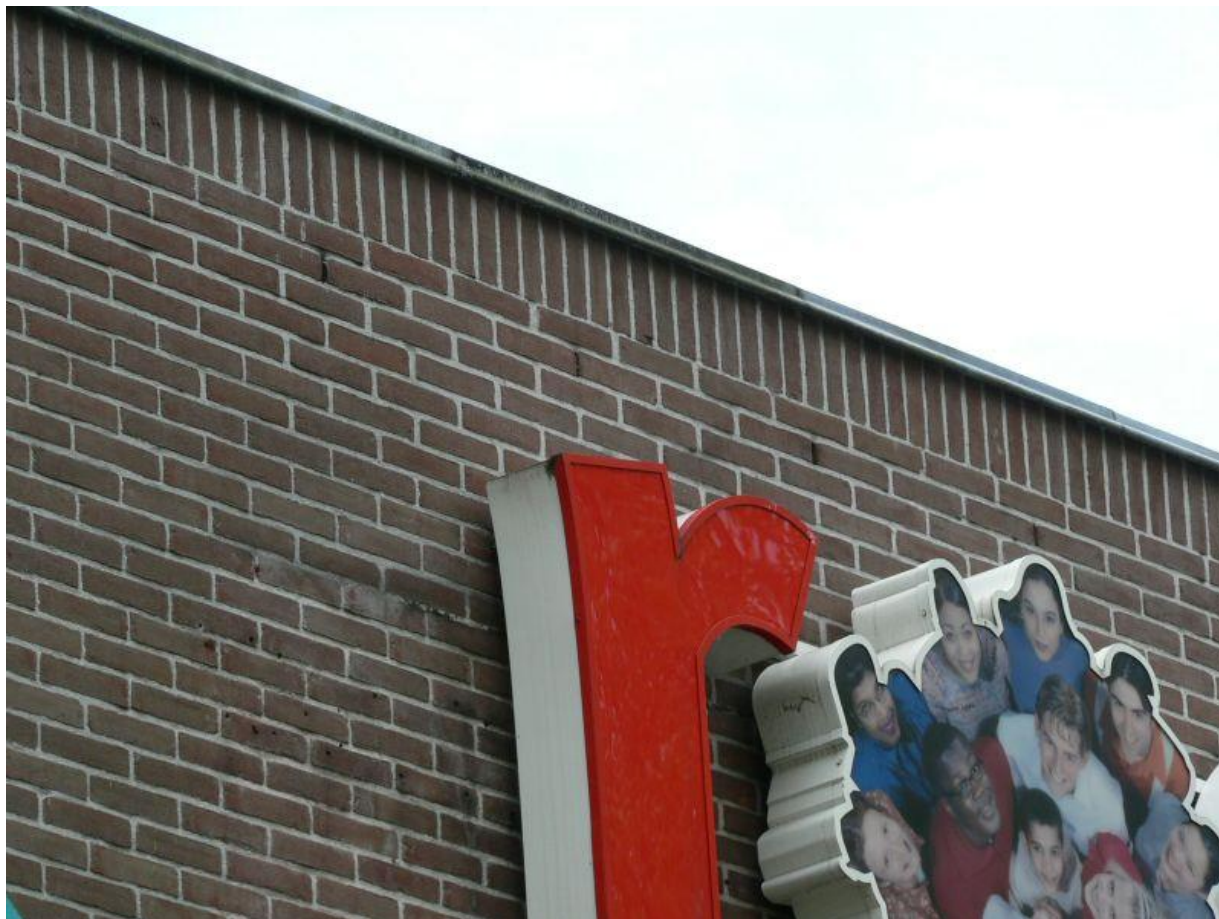
De gevel van het ROC-gebouw met open stootvoegen
