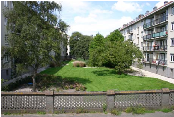
Groen in de wijk: zicht op de gemeenschappelijke tuinen, hier vanaf de stoep van de Jan van Galenstraat naar die van de bebouwing aan de James Rosskade en Erik de Roodestraat. Juli 2009, BMA.
