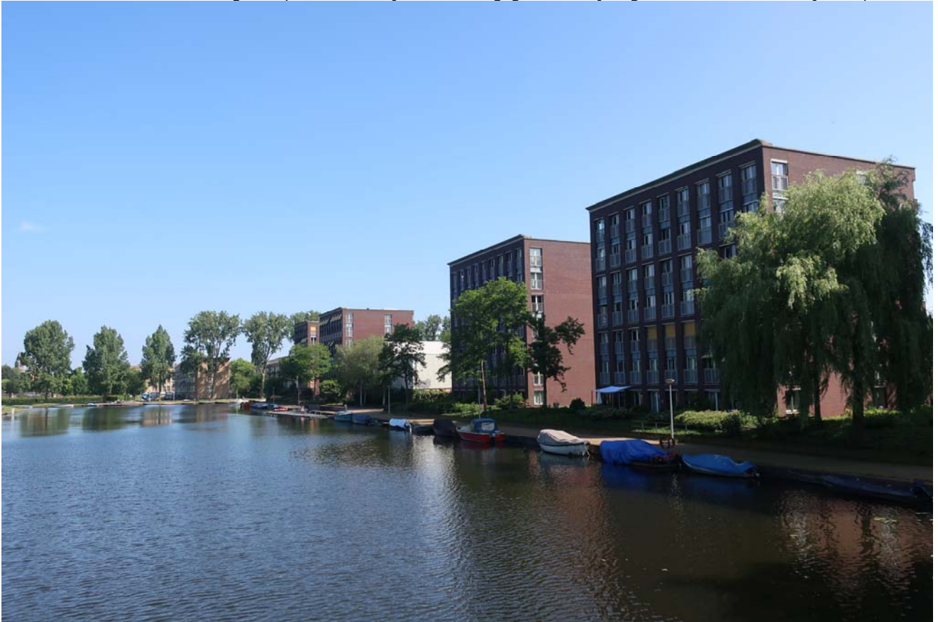
De nieuwbouw aan de Erasmusgracht pakt het motief van ritmering, groene omlijstingen en uitstekende daklijsten op.
