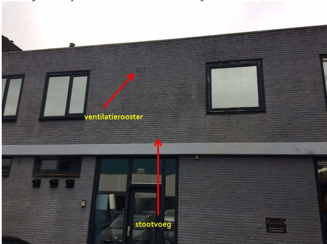
Geschikte verblijfplaatsen voor vleermuizen in bebouwing
