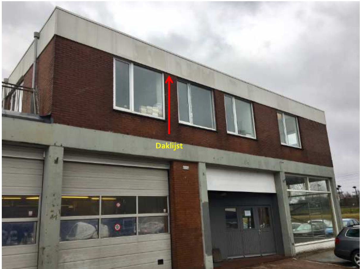
Geschikte verblijfplaatsen voor vleermuizen in bebouwing
