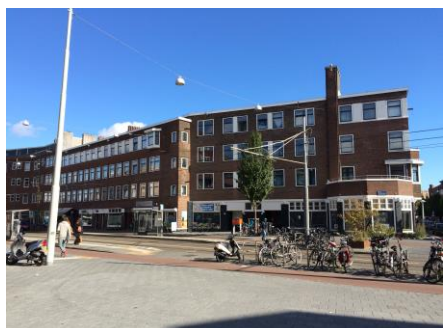
Afbeelding: Witte de Withstraat (oostzijde), ter hoogte van de Van Kinsbergenstraat
