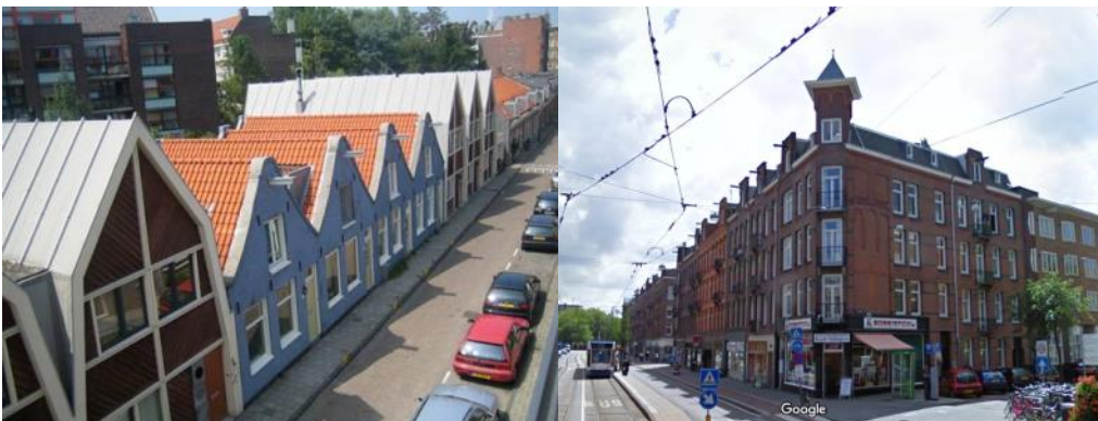
Zadeldaken oudbouw/nieuwbouw Slatuinenweg. Rechts daken dwars op Adm. de Ruijterweg en torentje op afgeschuinde hoek
