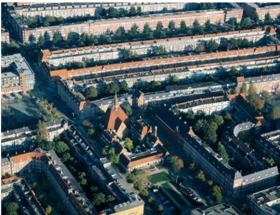
Links dakenlandschap, bestaande uit verschillende type daken, Magalhaensplein e.o.
