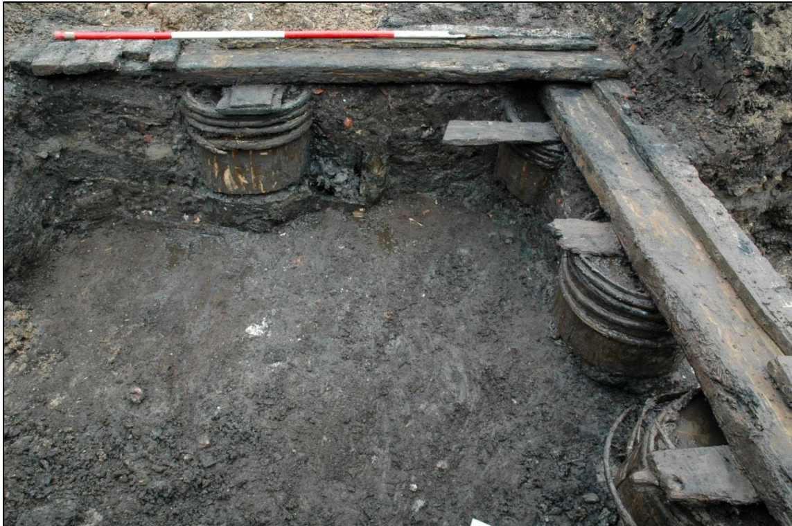
10 Fundering op tonnen van het houten gebouw (TKK).
