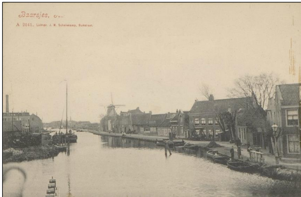
5 Zicht in zuidwestelijke richting vanaf de ophaalbrug over de Kostverlorenvaart aan het begin van de 20ste eeuw. Het tweede gebouw van rechts was de voormalige herberg de Drie Baarsjes. In de verte is krijtmolen de Hoop (1782-1921) zichtbaar. Prentbriefkaart, ca. 1910 (SAA).
