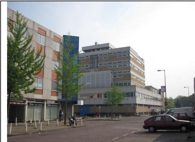
Het kantorenpand tussen het ABC-gebouw en de molen in is 18 tot 20 meter hoog. Dit veroorzaakt in de huidige situatie al veel windbelemmering bij winden uit westzuidwestelijke richting.
