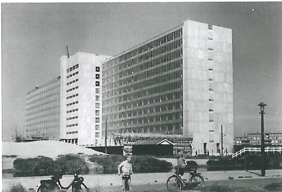
Het Gemeentelijk Administratiekantoor in aanbouw in 1959. (foto: J.M. Arsath Ro'is).
