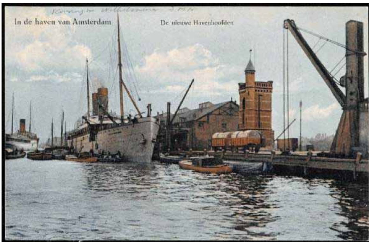
5 De Handelskade vanuit het noordwesten met spoorweg, door A.L. van Gendt ontworpen loodsen, hijskranen en watertoren (prentbriefkaart 1905, SAA)
