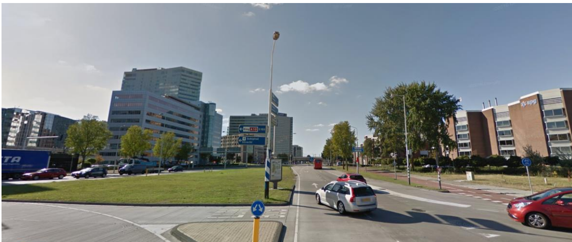
Figuur 18: Basisweg noordelijke rijbaan, blik naar het westen vanaf viaduct A10
