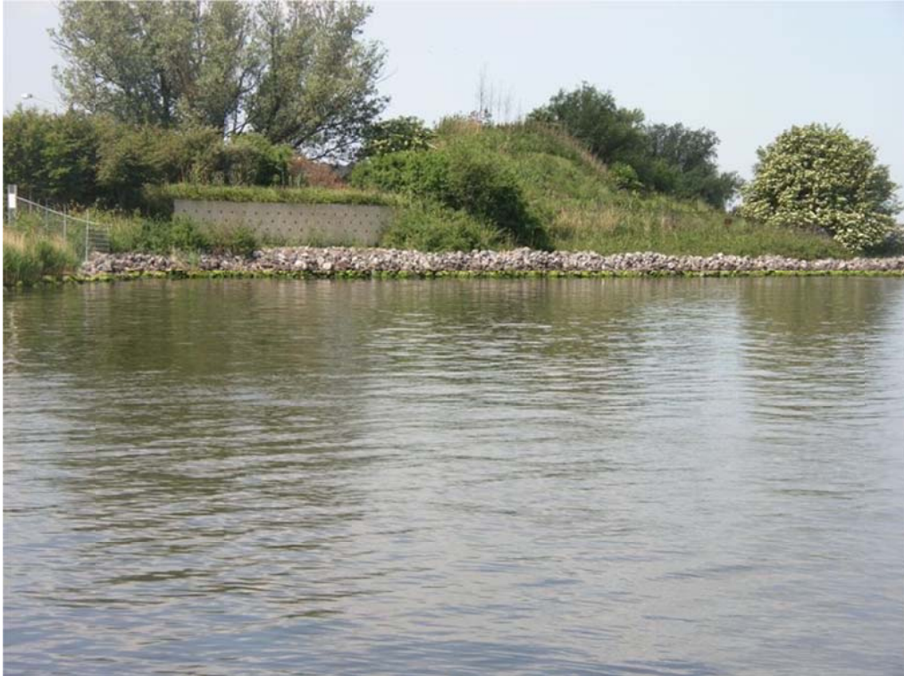
Oeverwaluwand bij de Hemweg
