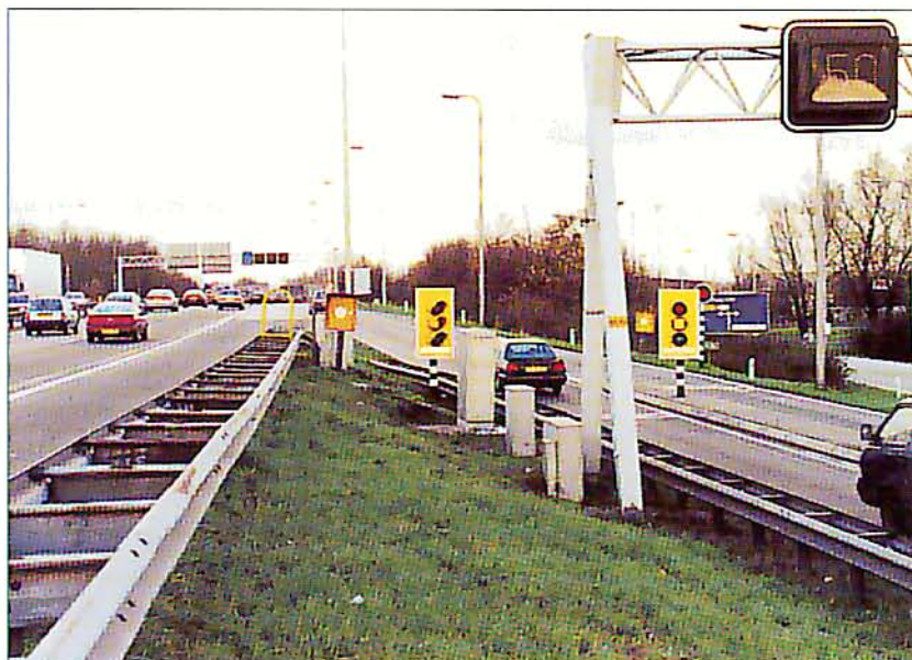
..... Toerit vanaf Hempoort naar de A10 vlak voor de Coentunnel (S101)
