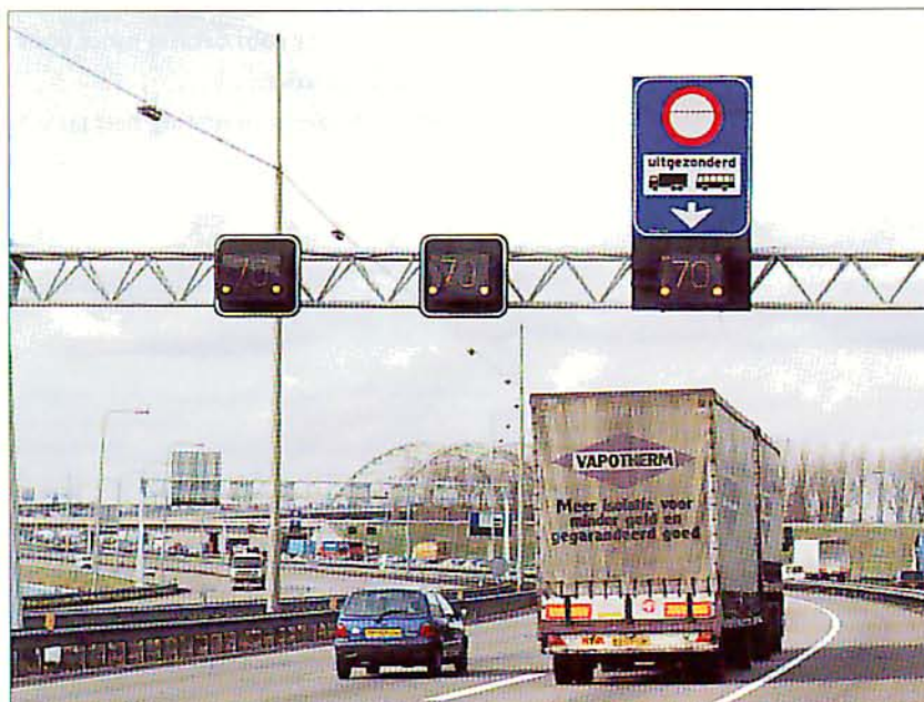
Een voorbeeld van een doelgroepstrook voor bussen en vrachtverkeer (A16)
