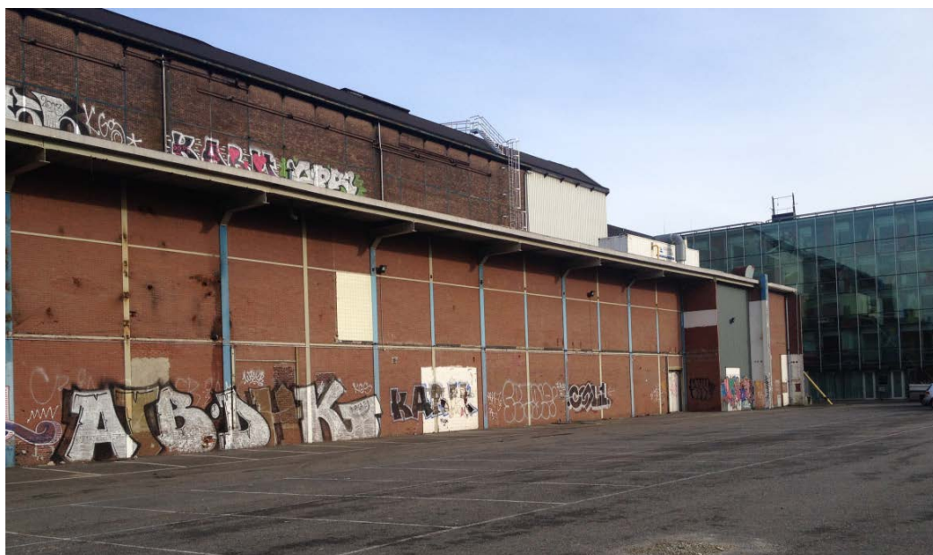
Fig. 5 Te slopen gebouw met mogelijke zomerverblijfplaatsen van vleermuizen
