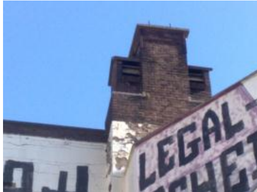
Figuur 6-3. Schoorstenen van de Tweede Chirurgische Kliniek: voorbeelden van structuren die zullen worden aangepast als permanent winterverblijf.
