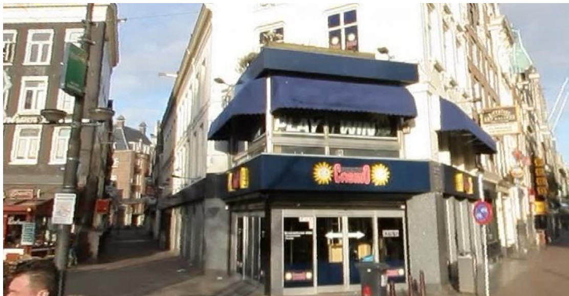
Rembrandtplein 2, driehoekige uitbouw
