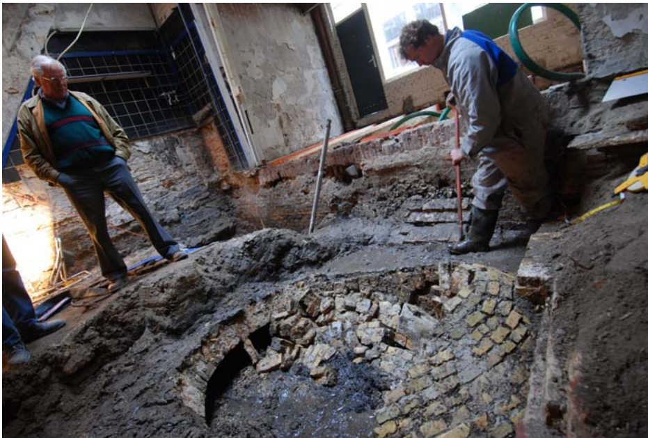
13 Archeologische Begeleiding funderingsherstel Spuistraat 30 (SP5), 2009. De putmantel en koepel waren uitgevoerd in één-steens metselwerk van gele baksteen.
