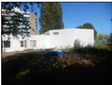
Figuur 3. Synagoge vanaf het zuiden.
